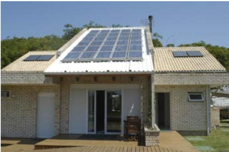
A casa conta com aquecimento solar da água. Para isso foram utilizados dois conjuntos de placas coletoras, com 1,4 metros quadrados cada e um boiler que permite deixar a água aquecida por até sete dias. Um dos sistemas é destinado ao aquecimento de água para banheiro – economizando no chuveiro - e cozinha e o outro aos quartos.
